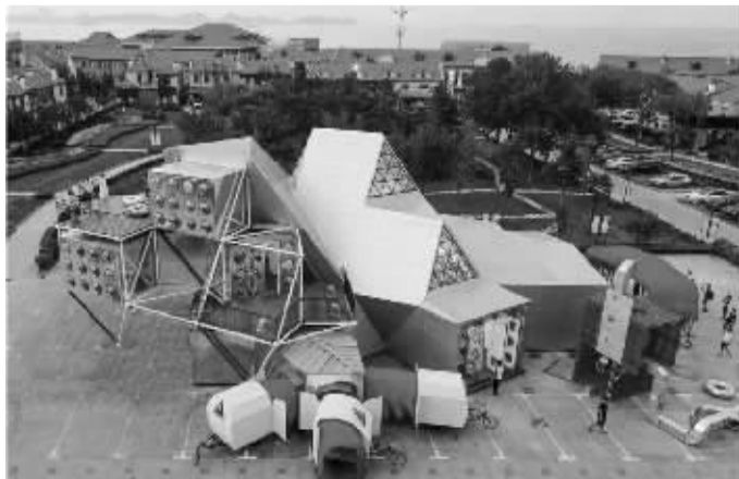
“广仁众空间”是众建筑在烟台的一片滨海历史街区中插入的预制建筑,由预制插件组装建成。图片据《IT 经理世界》
