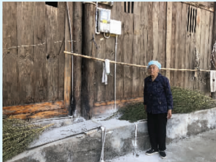
年过九旬的老人和她经改造过后的房屋,新安装的电表下仍清晰可见改造前的起火痕迹
